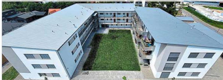
So sieht die fertige Wohnanlage an der Landrat-Ostermeier-Straße aus der Luft aus. – Foto: SozWohn
